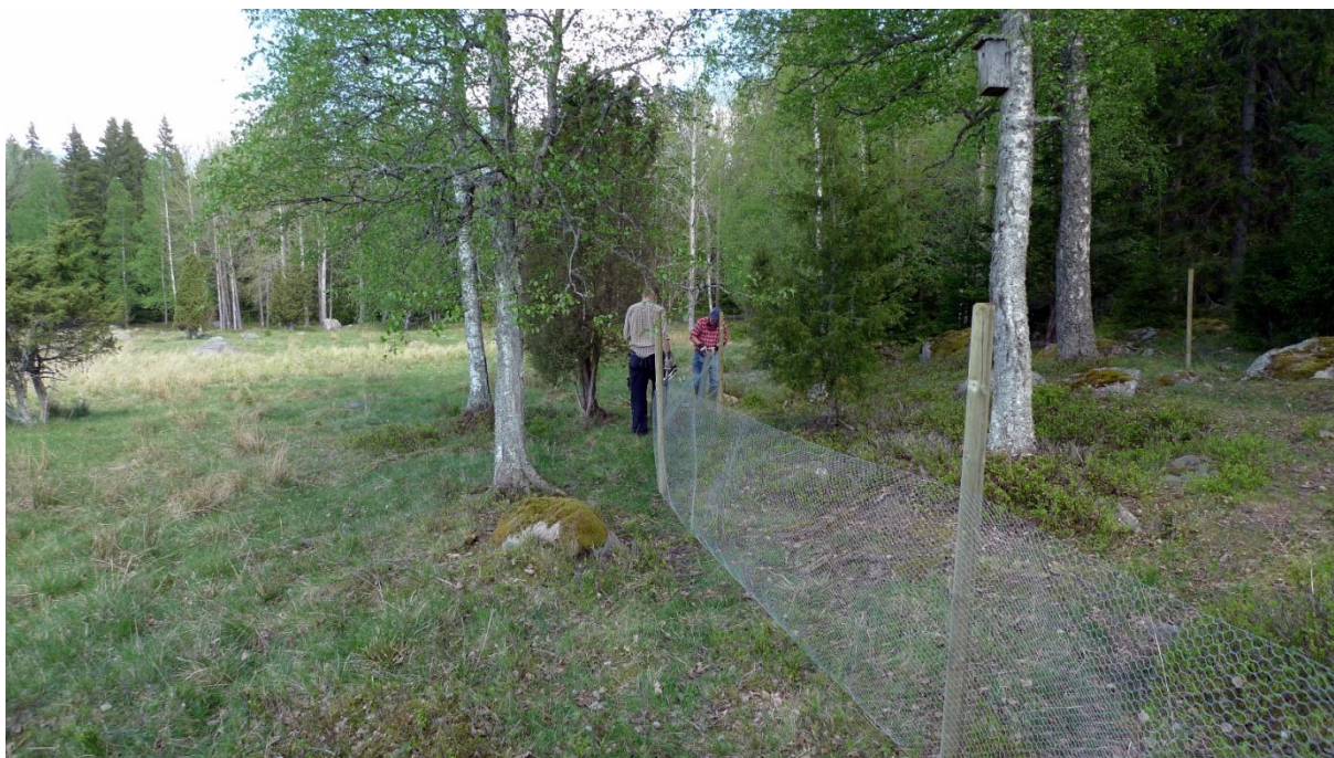
Tom och Einar har påbörjat arbetet med att bygga en inhägnad.
